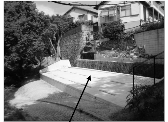
南前川の浸水対策工事（水量が増加すると調節池に水が流れ込み下流の流量を調節します）
